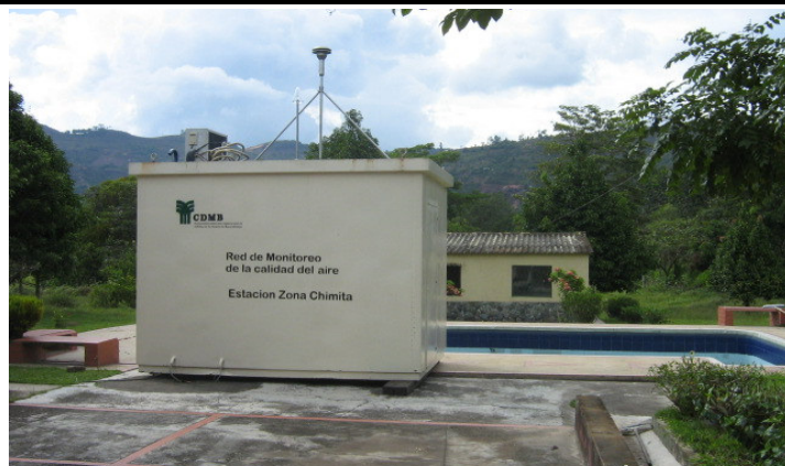
Estacion instalada en el nuevo Lote de Hipinto - Piedecuesta
