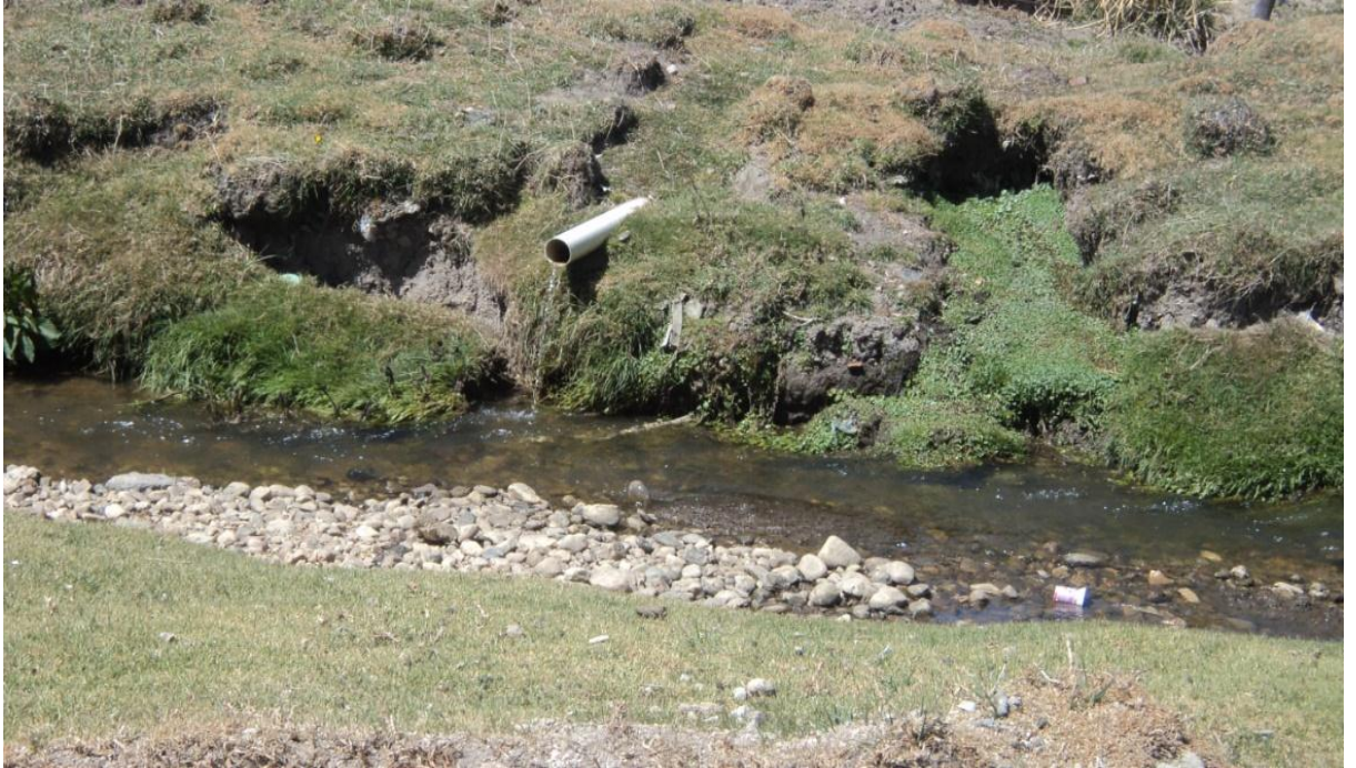
Descarga de Aguas residuales
