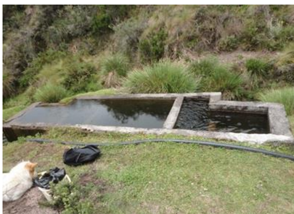
Foto 13 Desarenador del sistema de abastecimiento
