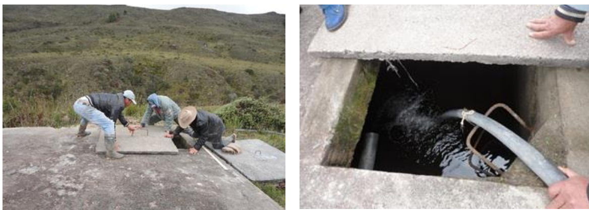
Foto 14 Tanque de almacenamiento del sistema de abastecimiento
